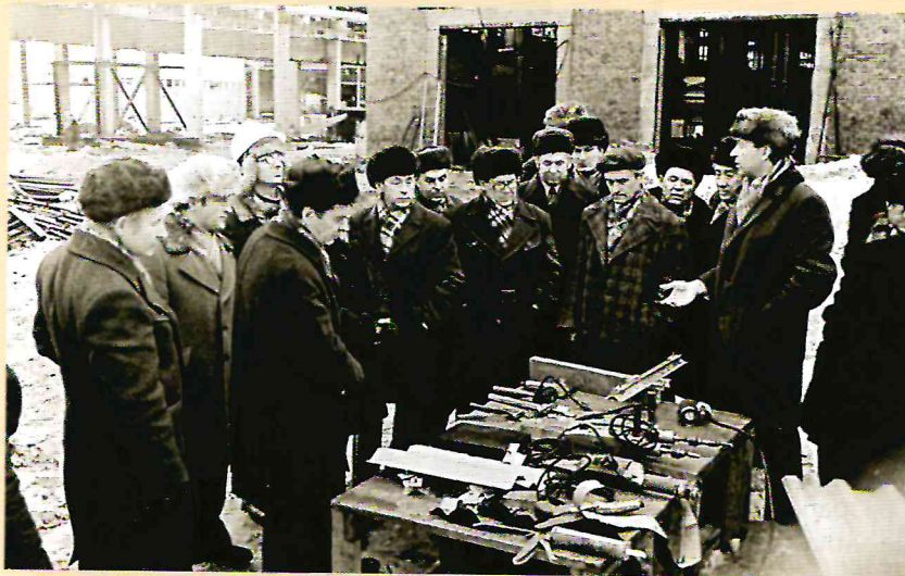
Совет главных инженеров трестов Главзападуралстроя проводит работу в г. Березники (докладывает Н. Н. Бельбов – крайний справа)
