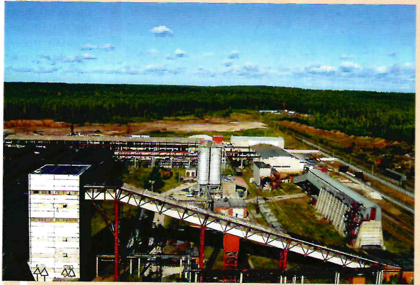
ПЗСП. Производство № 2. Панорама вспомогательных цехов тяжелого бетона
