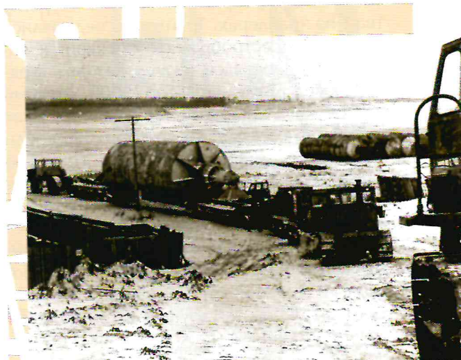
г. Пермь, Нижние Муллы, перевозка колонн стирола с причала на ПО «Пермнефтеоргсинтез» по зимнику (временная дорога)
