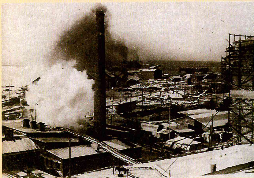
Строительство Березниковского химкомбината
