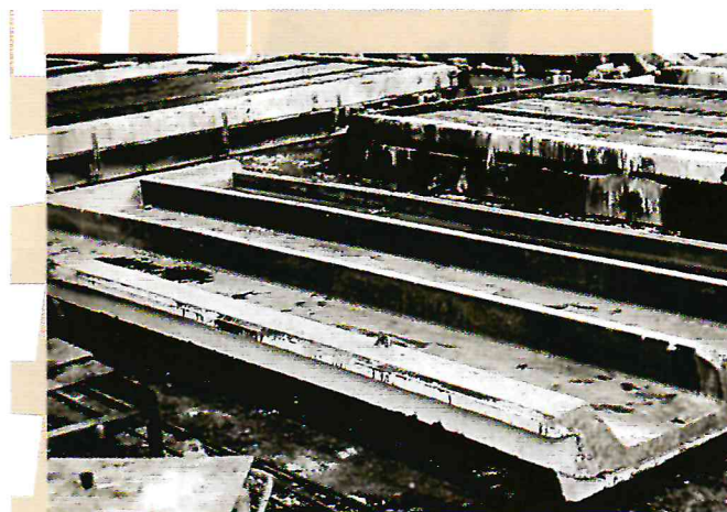
Безрулонная кровля из железобетонных плит на девятиэтажном доме серии 1-464-Д
