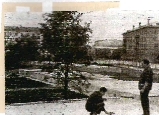
Строительная площадка по ул. Тимирязева, 50, 52, 54 перед началом монтажа зданий. Закончены все работы нулевого цикла.
