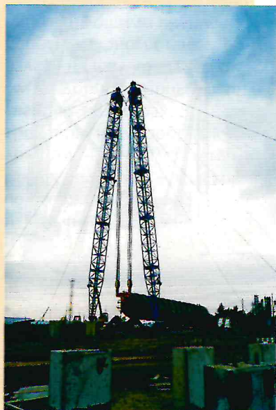
г. Пермь, ПО «Пермнефтеоргсинтез», комплекс глубокой переработки нефти, подъем колонны весом 840 тонн – реактора гидрокрекинга
