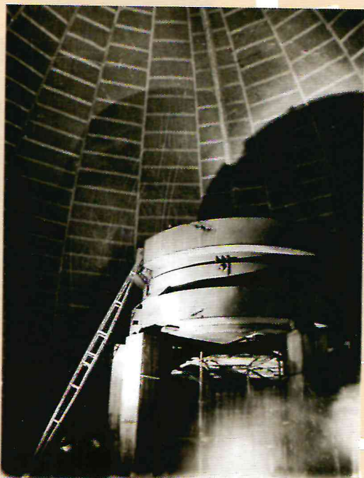
г. Пермь, Пермский химзавод, комплекс фталевого ангидрида. Сварка реактора под оболочкой
