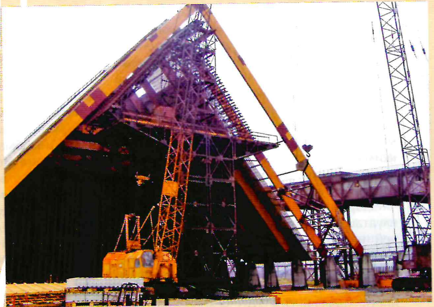
Монтаж линейных А-образных арок на складе калийного комбината г. Березники
