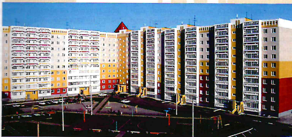
Совершенствование жилых домов серии Э-600-П. Застройка микрорайона по ул. Докучаева (ОАО «ПЗСП»)
