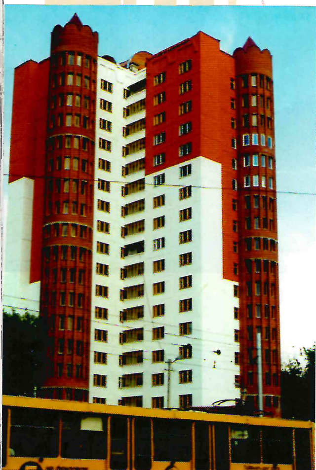
Модернизация серии 111-97-П. Шестнадцатизэтажный крупнопанельный жилой дом с эркерами из кирпича по ул. Толмачева, 17 (ООО «Горсельстрой»)
