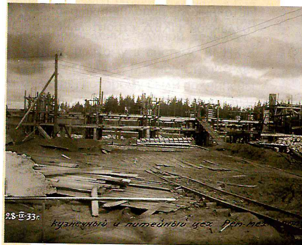
Строительство КЦБК. Кузнечный и литейный цех ремонтно-механического корпуса
