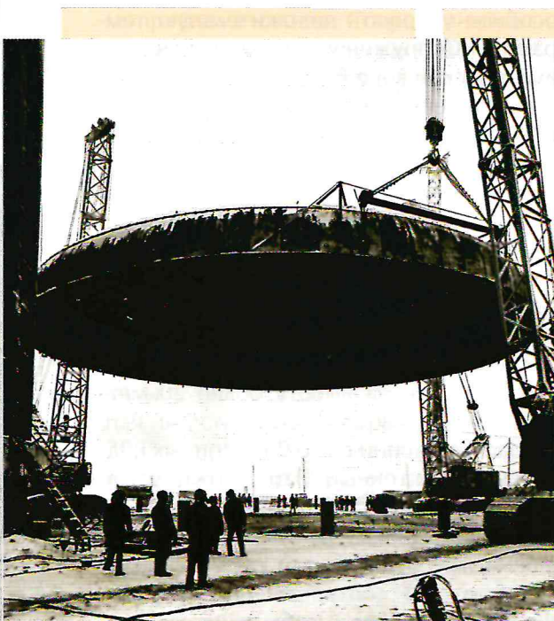
г. Березники, азотно-туковый завод, изотермическое хранилище аммиака, подъем внутренней торовой крыши тремя кранами
