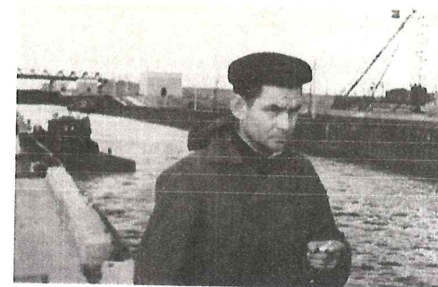
Шлюз Камской ГЭС, 1955 год
