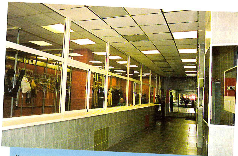
Гардероб строительного факультета после реконструкции
