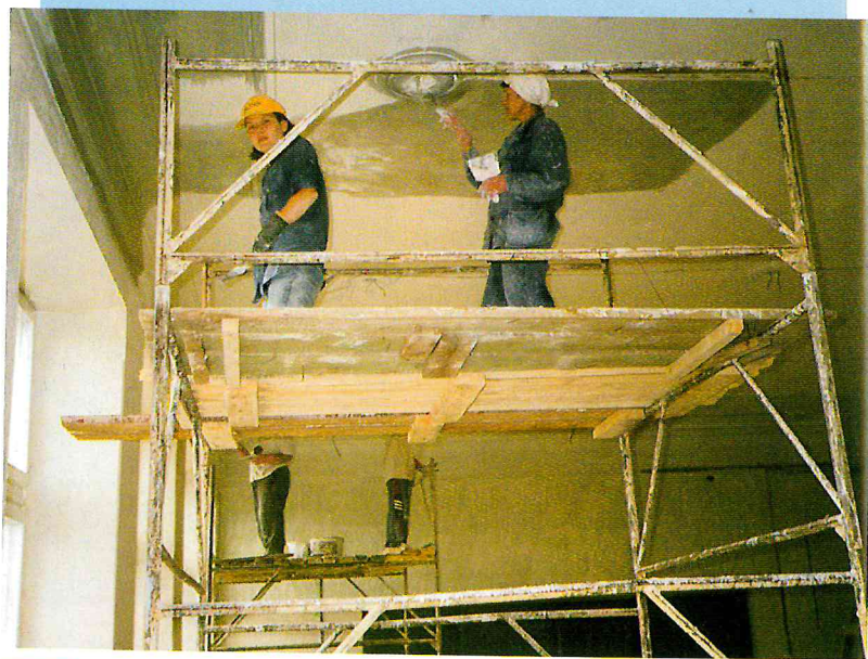
Работа по отделке ауд. 407 выполняет ОАО «Трест № 14»
