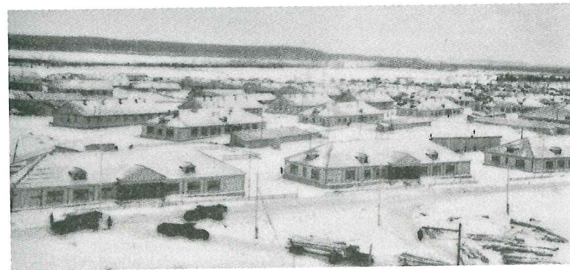
Поселок строителей ВГЭС
