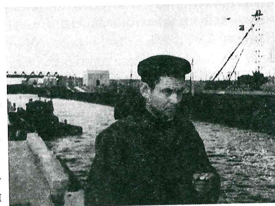
Камский шлюз 1955 года. Инженер ПТО М. С. Плеханов производит хронометраж работы механизмов шлюзовых ворот
